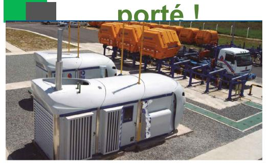
En milieu rural, la technologie « Racks » permet de s'affranchir du réseau de distribution de gaz pour faire de l'injection portée.
