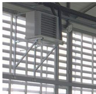
Aérotherme du gymnase
