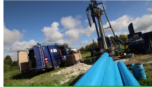
Chantier sur nappe
