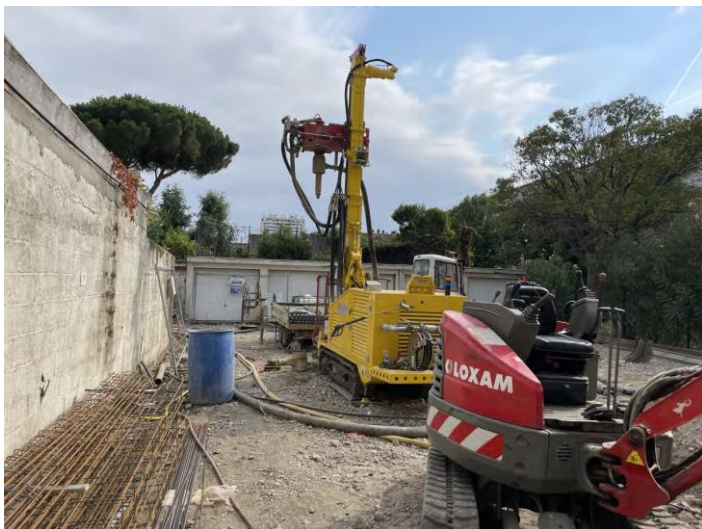
Réalisation forage F3
