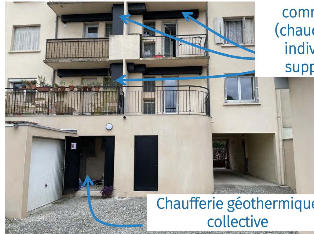
Après (chaufferie collective avec PAC géothermique)
