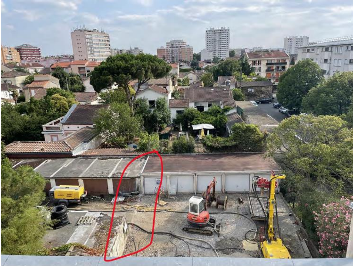
Vue générale du chantier et environnement lors de la phase de forage. A gauche : équipement installé sur la propriété voisine après destruction du mur mitoyen. Les engins de forage ne passant pas sous le porche, l'accès via la propriété voisine était indispensable à la réalisation du projet.
