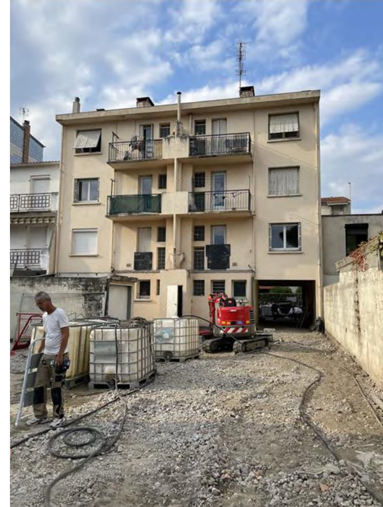
Le chantier a rendu le stationnement impossible pour les occupants de l'immeuble pendant environ 40 jours.
