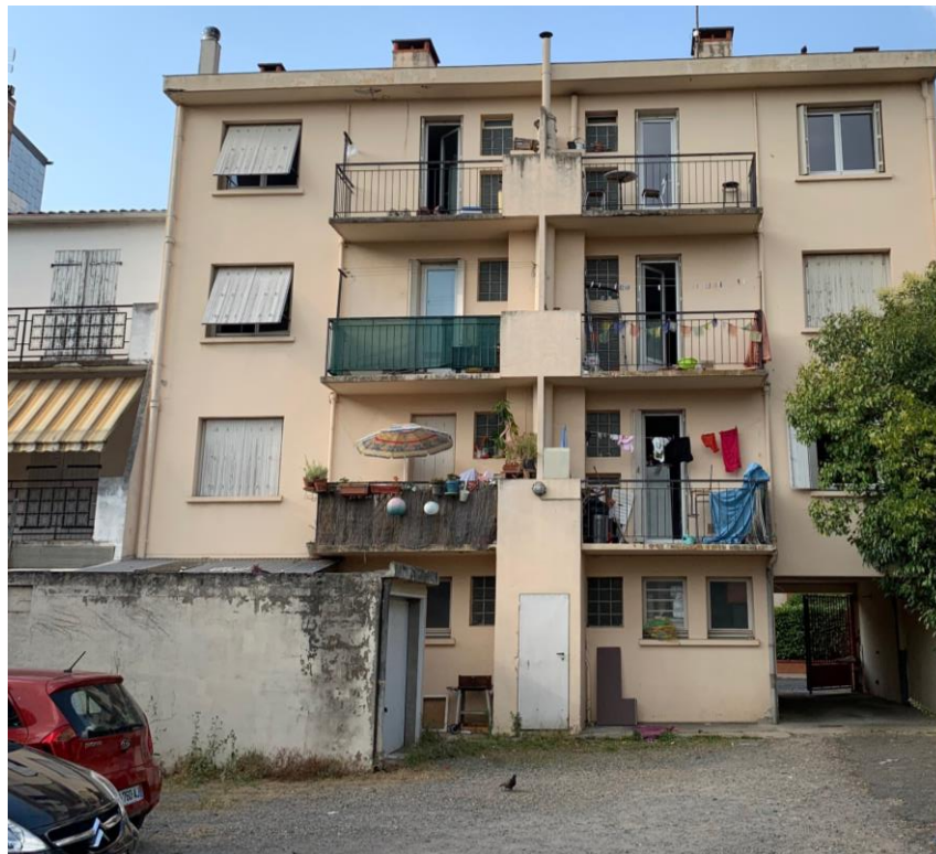
Avant (chaudières gaz individuelles)
