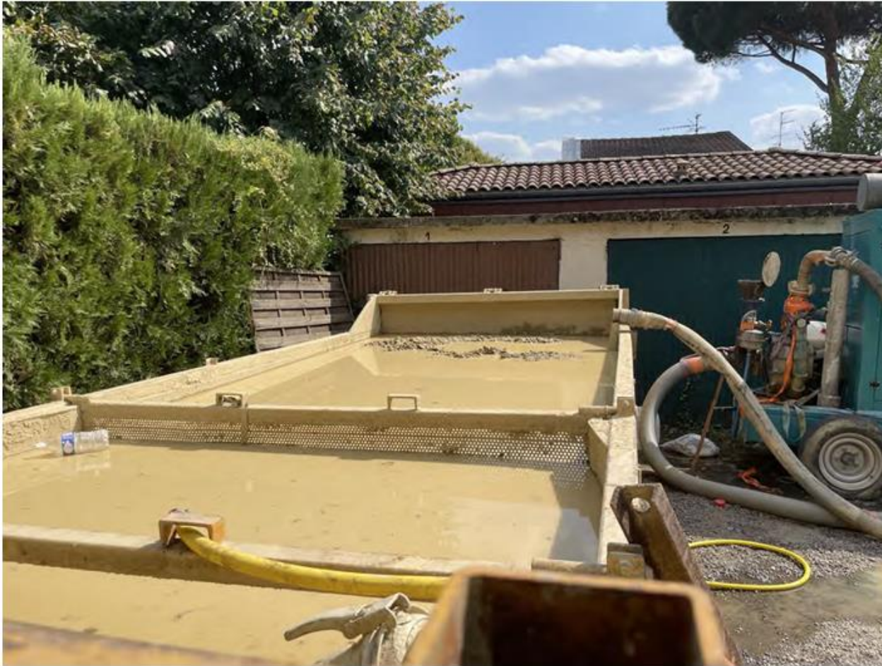
Equipment de forage installé sur la propriété voisine
