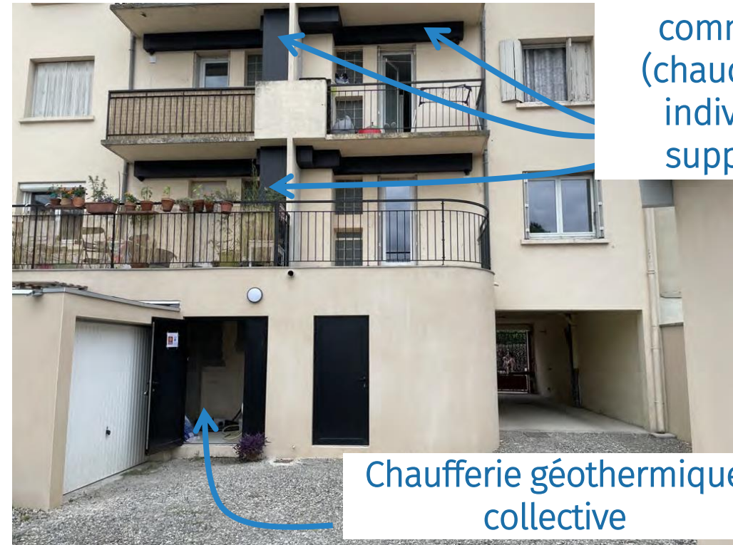
Après (chaufferie collective avec PAC géothermique)
