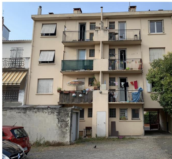
Avant (chaudières gaz individuelles)
