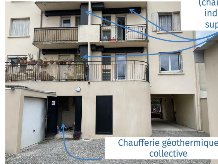
Après (chaufferie collective avec PAC géothermique)
